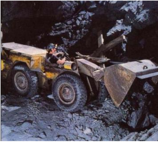
Miramar Con Mine Ltd.
