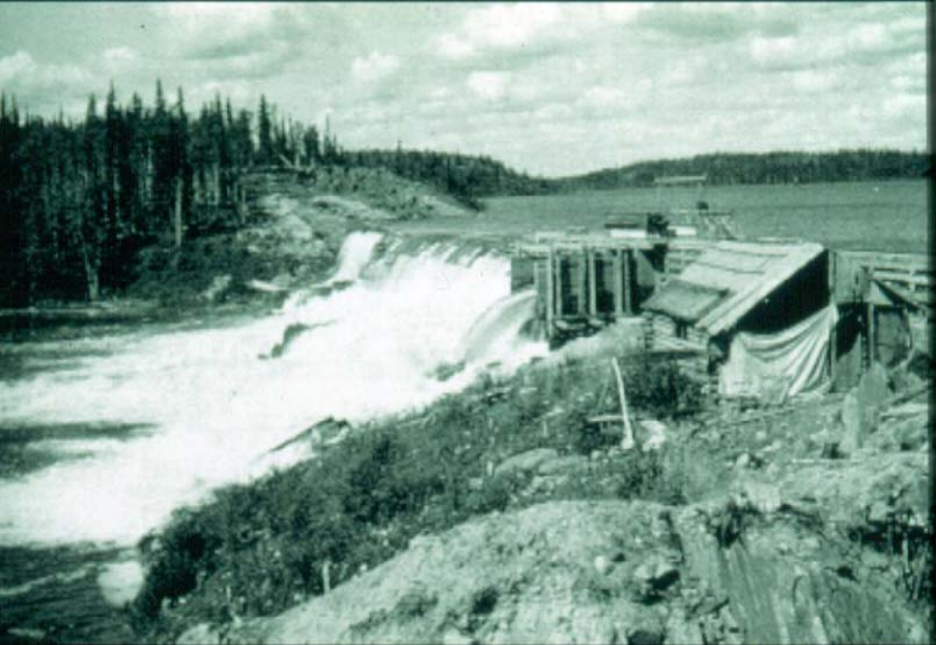
Con Hydro Dam – Con Mine
